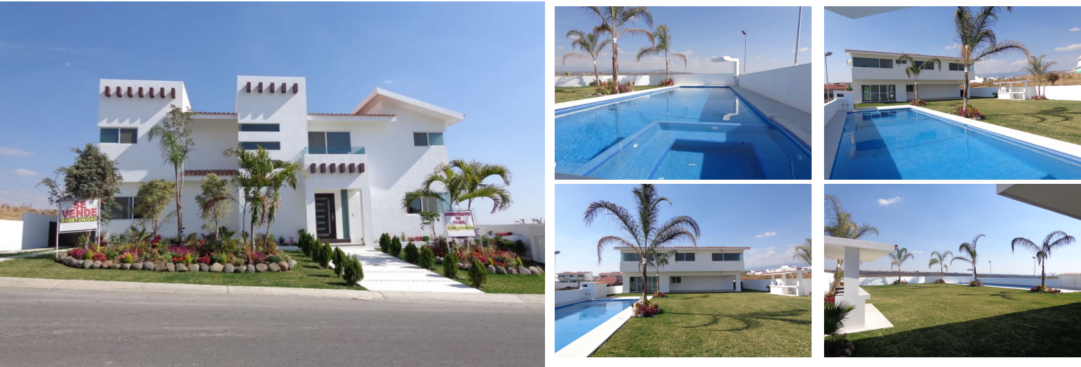
Dos niveles, área de lavado
